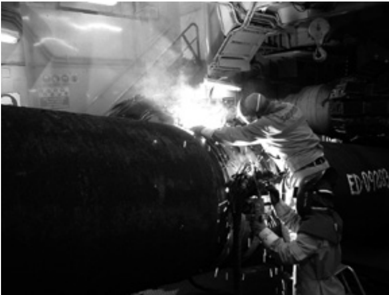
Twee van de 200.000 leidingen in de Nordstream worden op een pijpenlegger aan elkaar gelast. Foto: wikipedia/bair175
